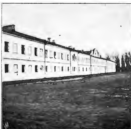
Внѣшній видъ зданія батальона.
