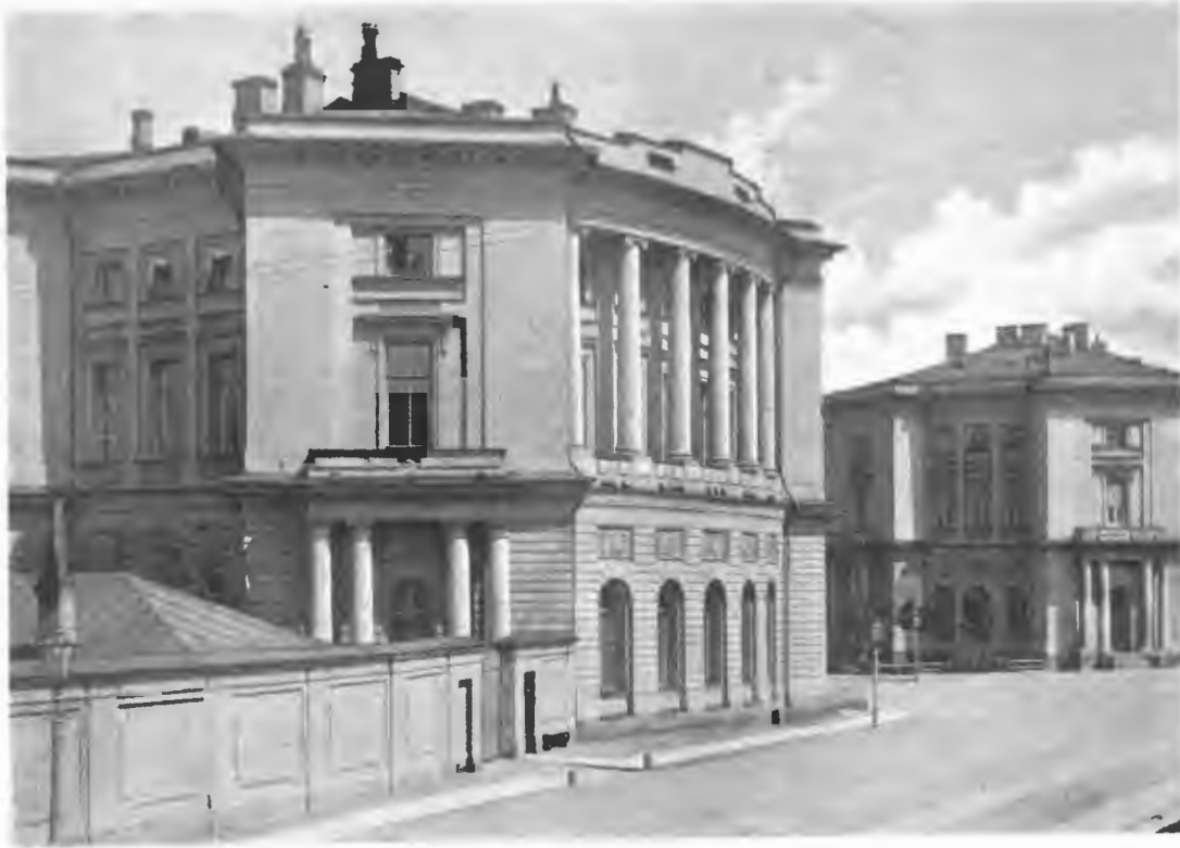
Видъ зданія Главнаго Училища Инженеровъ. (2-ое помѣщеніе со времени учрежденія школы).
